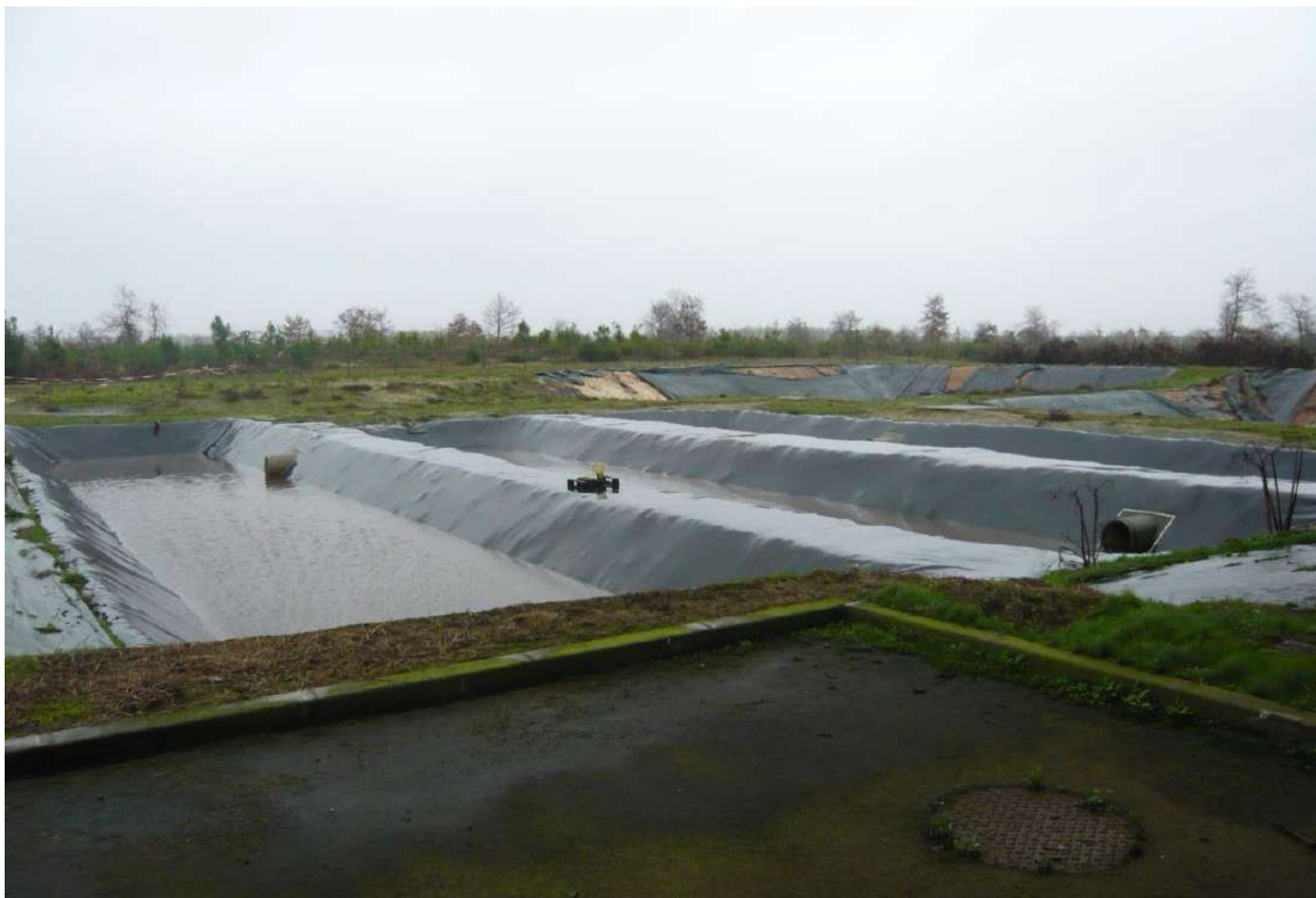
Figure 27 : Photographie 11 – Lagunes de traitement et bassins d'infiltration de l'usine
