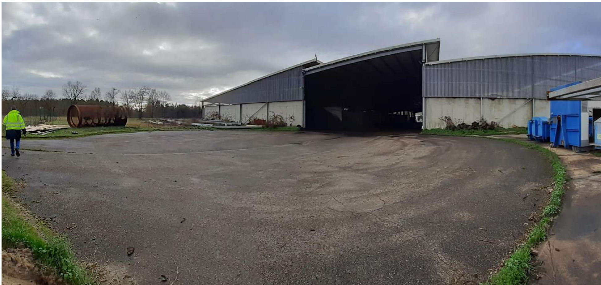
Figure 24 : Photographie 8 – Aire de retournement engins
