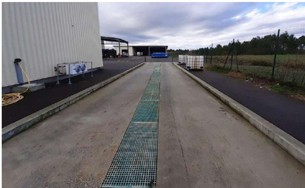
Figure 26 : Photographie 10 – Partie Nord de l’usine : aire de dépotage
